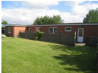
Das Grundstück der Familie Carstensen Im Bild: die Bungalows 1 und 2
