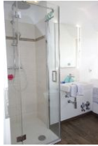
Die neue Duschkabine, flacher Einstieg
