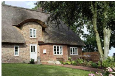
Das Haus WattGut in Oevenum
