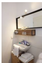
Das frisch (4/2023) renovierte Bad mit...
