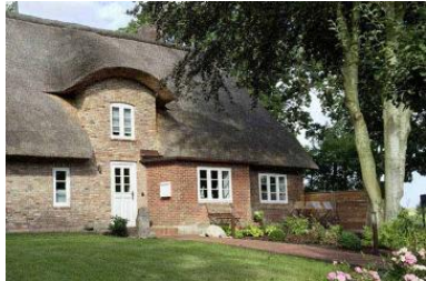
Das Haus WattGut in Oevenum
