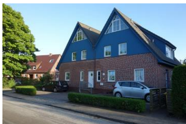
Das Haus Olhörnstieg 6, die Unterkunft befindet sich im Erdgeschoss links
