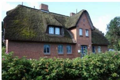
Das Haus Bredland 2a Die Whg.4 befindet sich im 1.OG links
