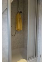
...und nicht zuletzt die Duschkabine.
