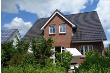
Das Haus Flurstrasse 28
