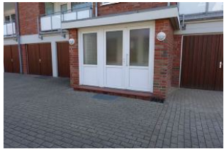
Der Eingang des Hauses mit einer Stufe
