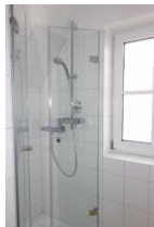
...Dusche, neu mit Glastür.
