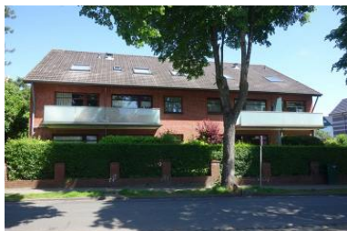
Die Aussenansicht des Hauses Feldstrasse 18
