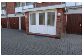
Der Eingang des Hauses mit einer Stufe
