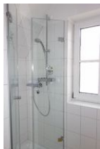
...Dusche, neu mit Glastür.
