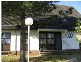
Die Haustür des Hauses Gmelinstr. 28 Haus 5
